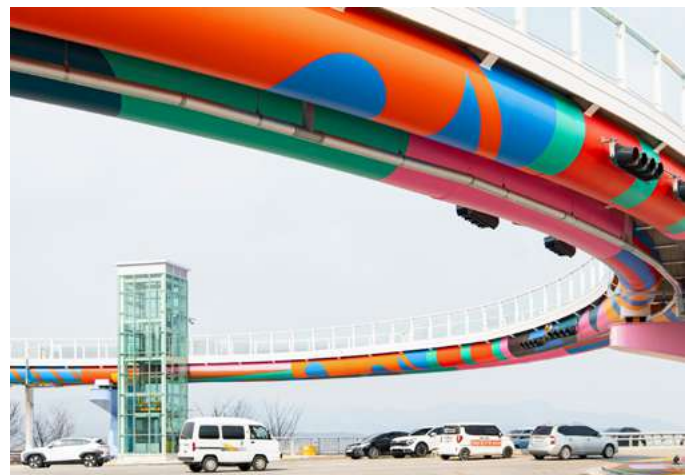
소양아트서클은 보행 폭 3m를 갖춰 안전한 통행을 유도한다. 강렬한 색감과 도형을 사용한 디자인으로 춘천의 자연을 표현했다.
